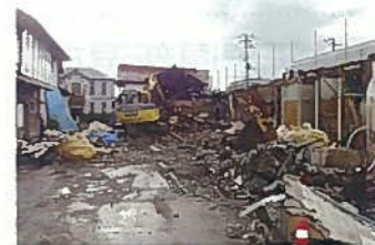
矢吹町の復旧作業
